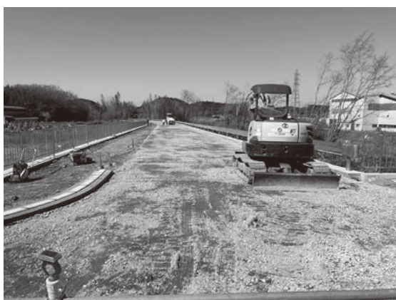
整備が進む町道川浦川左岸線（滝田地内）
