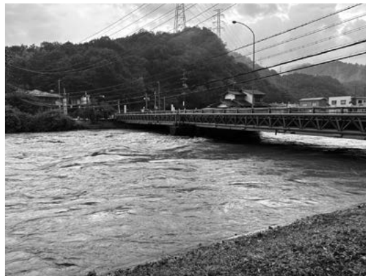
大山橋と水管橋のようす (令和5年8月16日 津保川の増水時)
