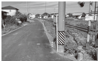
町単工事で整備された 町道羽生64号線(羽生地内)
