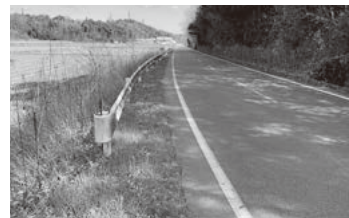
町道滝田69号線の道路法面のようす (大平賀地内)
