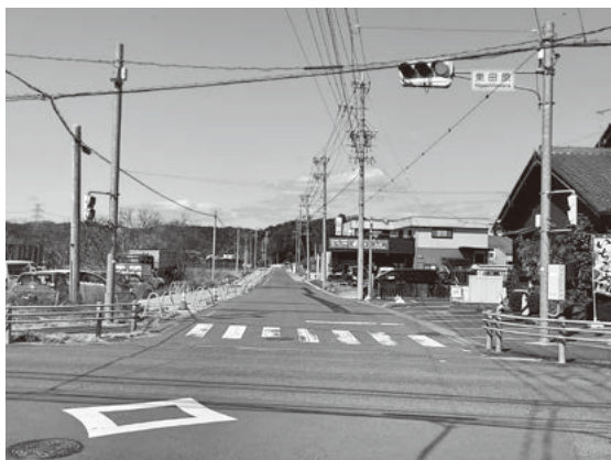
整備中の町道稲荷北野線（高畑地内）
