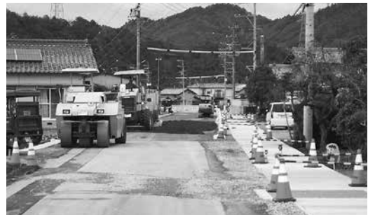
工事が進捗する町道西組木船線（大山地内）
