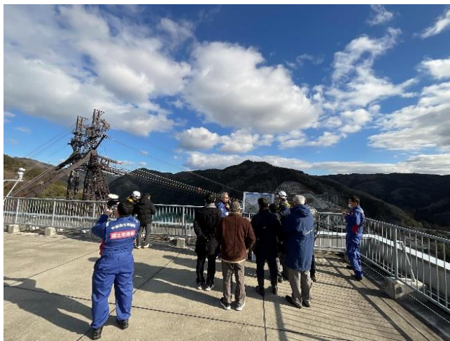
新丸山ダム工事現場
