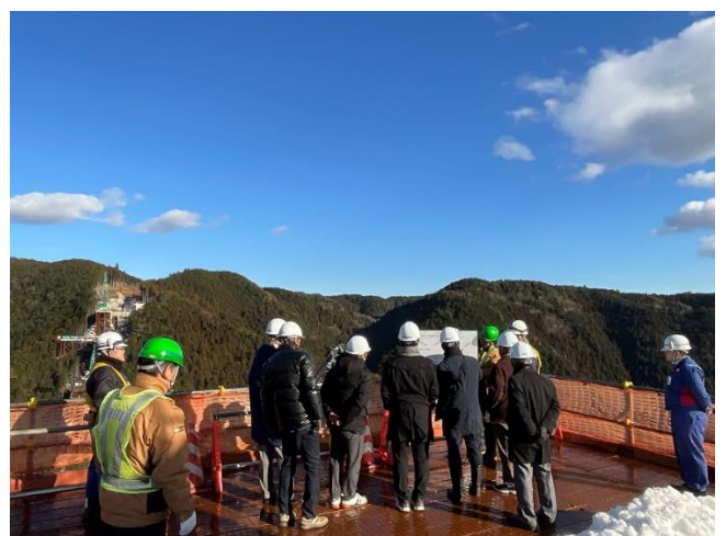
国道 418 号線付替工事現場 (アーチ橋)
