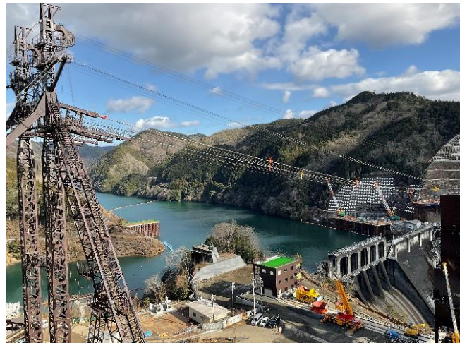
新丸山ダム工事現場
