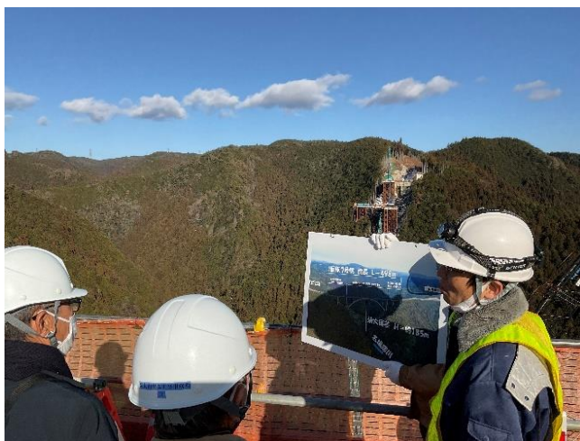
国道 418 号線付替工事現場 (アーチ橋)
