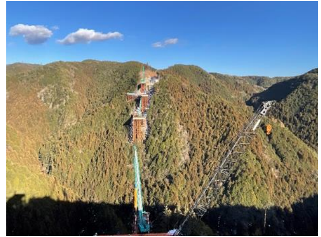
国道 418 号線付替工事現場 (アーチ橋)
