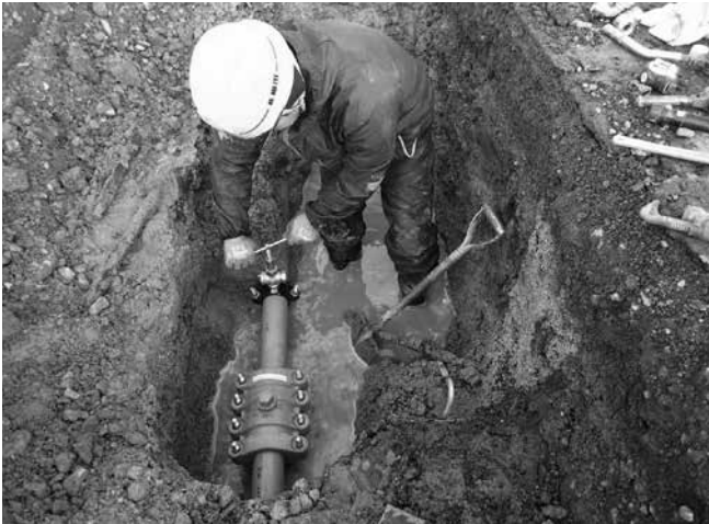
水道管工事のようす
