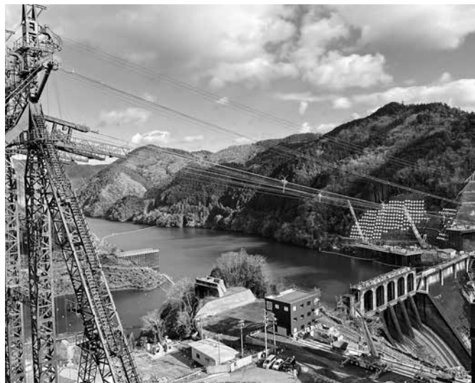
新丸山ダム工事現場
