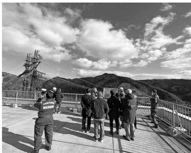
新丸山ダム工事現場
