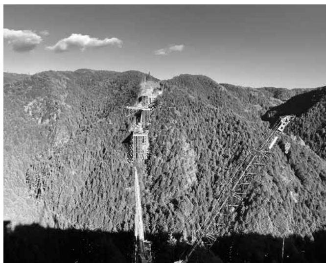
国道418号線付替工事現場（アーチ橋）
