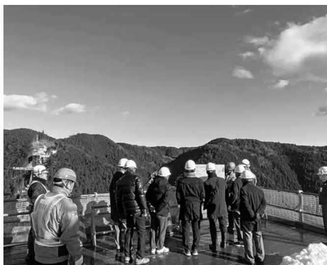
国道418号線付替工事現場（アーチ橋）
