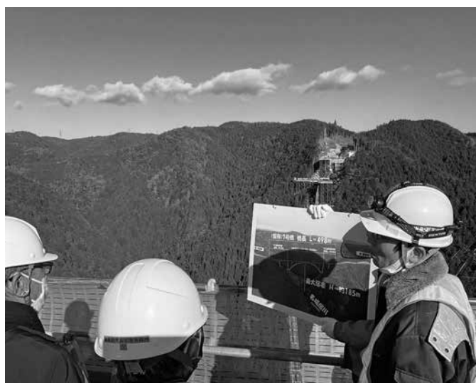
国道418号線付替工事現場（アーチ橋）
