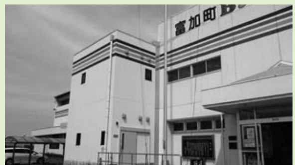
B&G海洋センタートイレ新設工事
