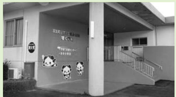
子育て支援センター改修工事
