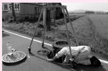
詰まった下水道の修理
