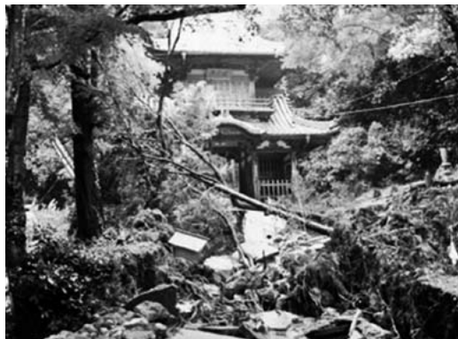
平成4年8月11日の集中豪雨で被害を受けた清水寺
