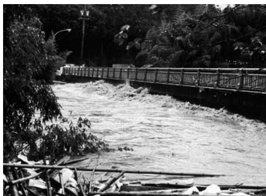
平成11年9月の豪雨により、津保川(鮎見橋)が増水
