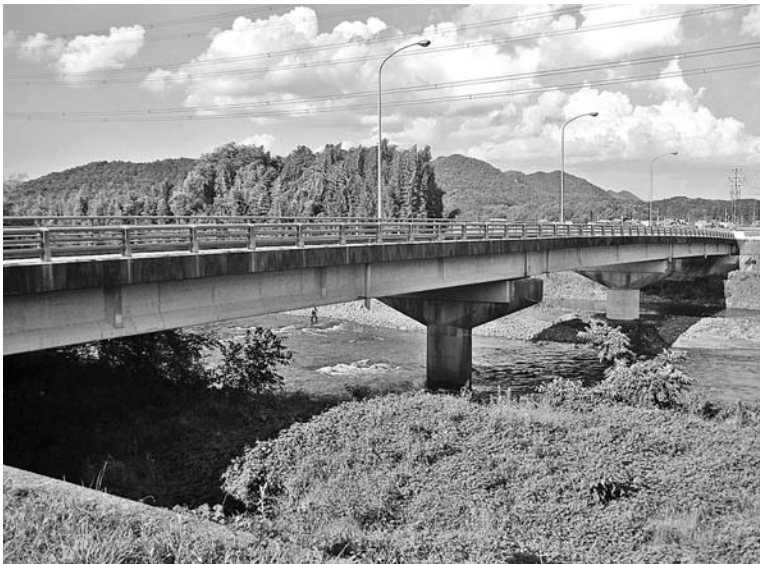
耐震補強工を行う津保川大橋
