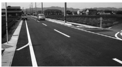
▲平成20年度に歩道など整備された町道 滝田・八反田線
