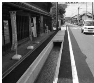
▲平成20年度に整備された縄丸用水路
