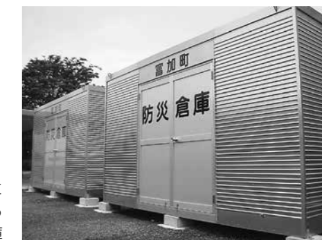
町内8か所に設置されている防災倉庫
