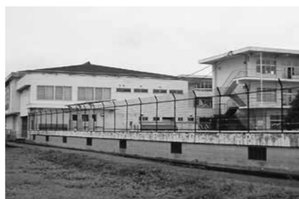
空調設備の設置を望む富加小体育館
