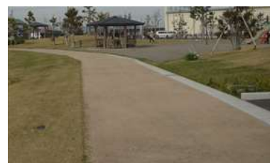
脱色アスファルト舗装
